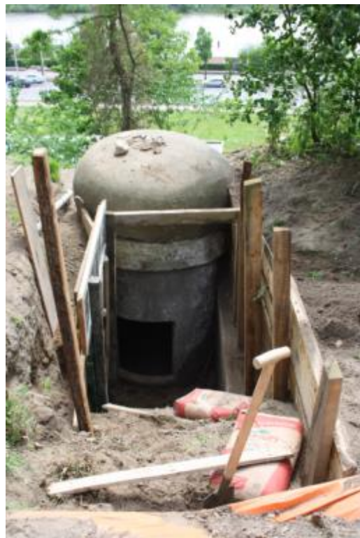
Afbeelding 41. Aanzicht met het rechthoekige gat, de scheve deksel en de positie op de stuwwal (foto: W. Schwabe).
