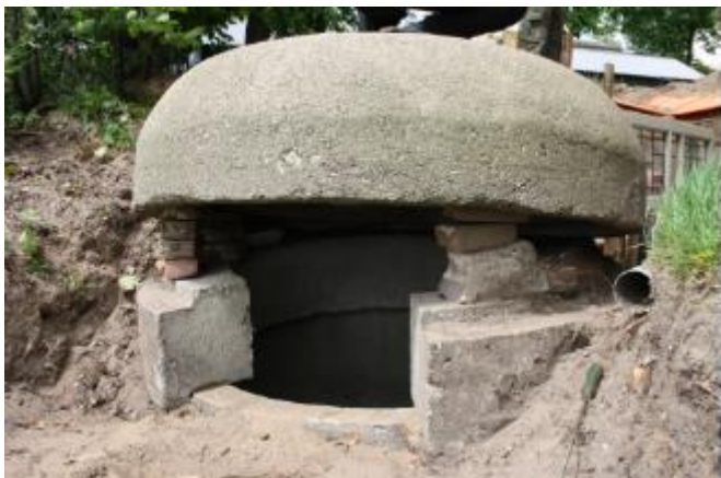
Afbeelding 40. De voorzijde met opening in de ring en geplaatste bakstenen na het uitgraven (foto: W. Schwabe).
