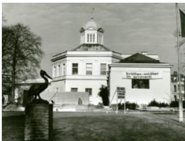
Afbeelding 32. Bouw aan de oostzijde van het museum, nabij de westelijke van de twee bunkers in de tuin (bron afbeelding: GldA, 1583 - Fotocollectie voormalig gemeentearchief Arnhem 2) .
