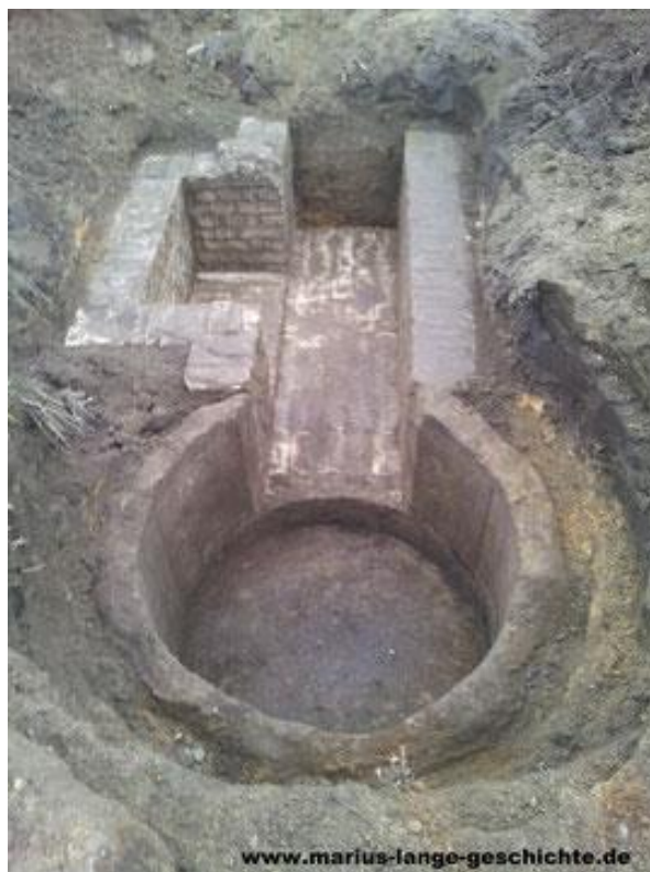
Afbeelding 25. Resten van een Kochbunker met de ruimte hierachter, zuidelijk van Bocholt te Duitsland (bron afbeelding: http://www.marius-lange-geschichte.de ).
