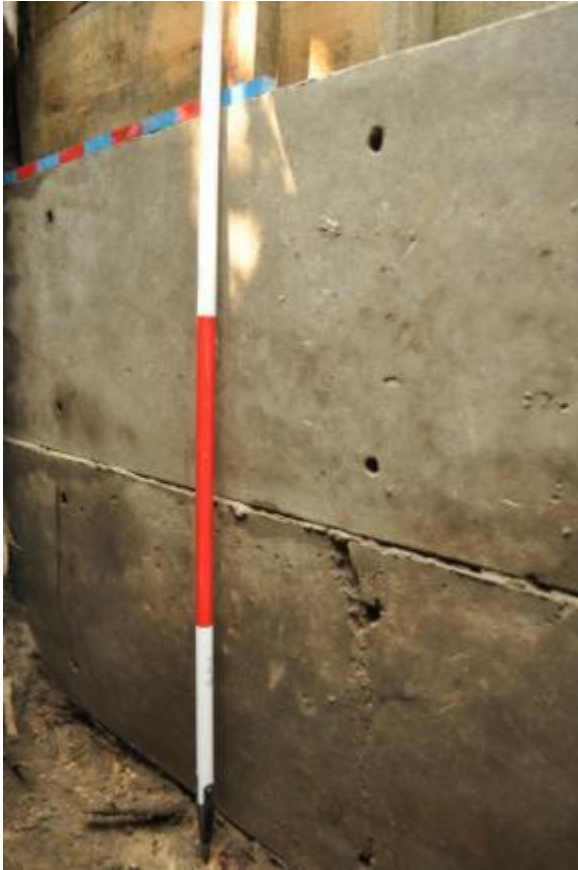
Afbeelding 45. Schuin genomen foto van het lange deel van de wand, met erboven hout van de reconstructie. De gelijk verdeelde gaten zijn duidelijk zichtbaar (foto: L. van Midden).
