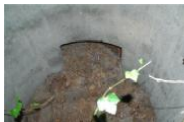
Afbeelding 38. De binnenzijde van de buis nog gevuld met zand en bladeren, bij de opening is de metalen plaat zichtbaar die de toegang aan de buitenzijde afsloot (foto: L. van Midden).
