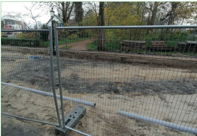
Grondspoor toegangspoort Weesp (foto: Anton Cruysheer).
